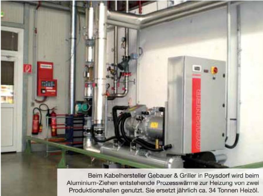
Beim Kabelhersteller Gebauer & Griller in Poysdorf wird beim Aluminium-Ziehen entstehende Prozesswärme zur Heizung von zwei Produktionshallen genutzt. Sie ersetzt jährlich ca. 34 Tonnen Heizöl.
