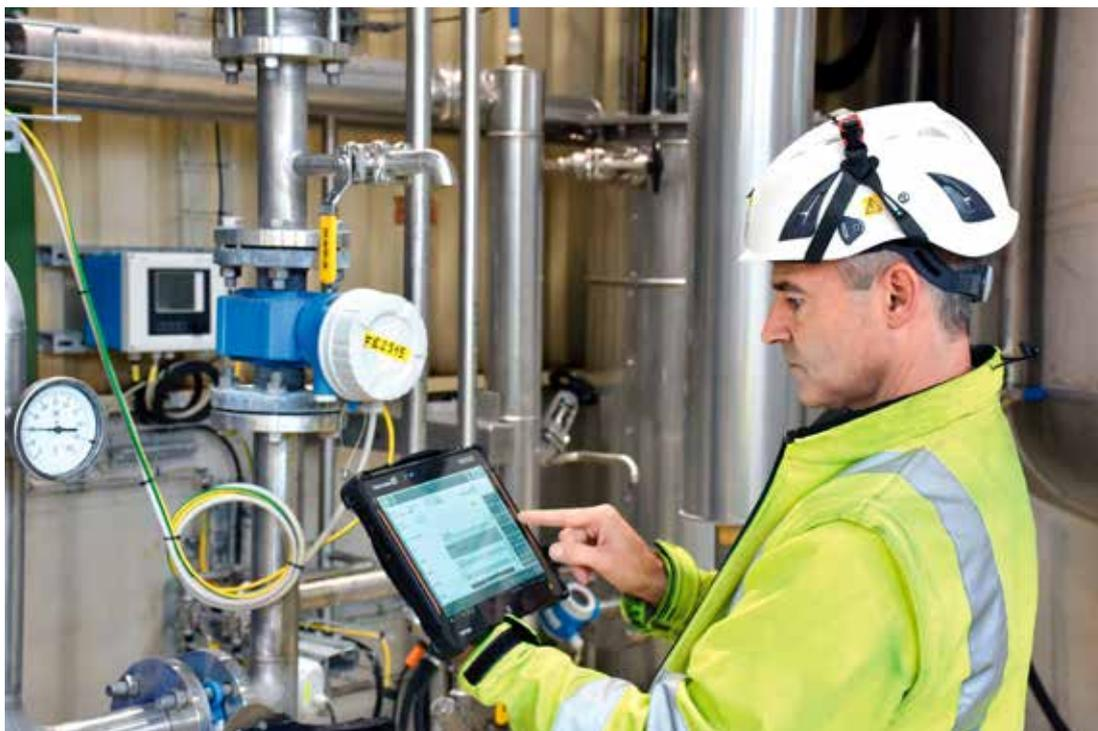
Vorinstallierte Gerätetreiberbibliotheken für alle relevanten industriellen Kommunikationsprotokolle ermöglichen es dem Field Xpert SMT70, **mit nur einem Klick Verbindung mit den Feldgeräten aufzunehmen.**
