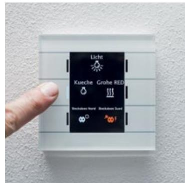
Ein moderner KNX-Glastaster kann bis zu 24 Aktionen steuern. Übergeordnete Automatisierungsaufgaben realisiert Robert Merz in zenon, das die KNX-Telegramme weiterverarbeitet.
