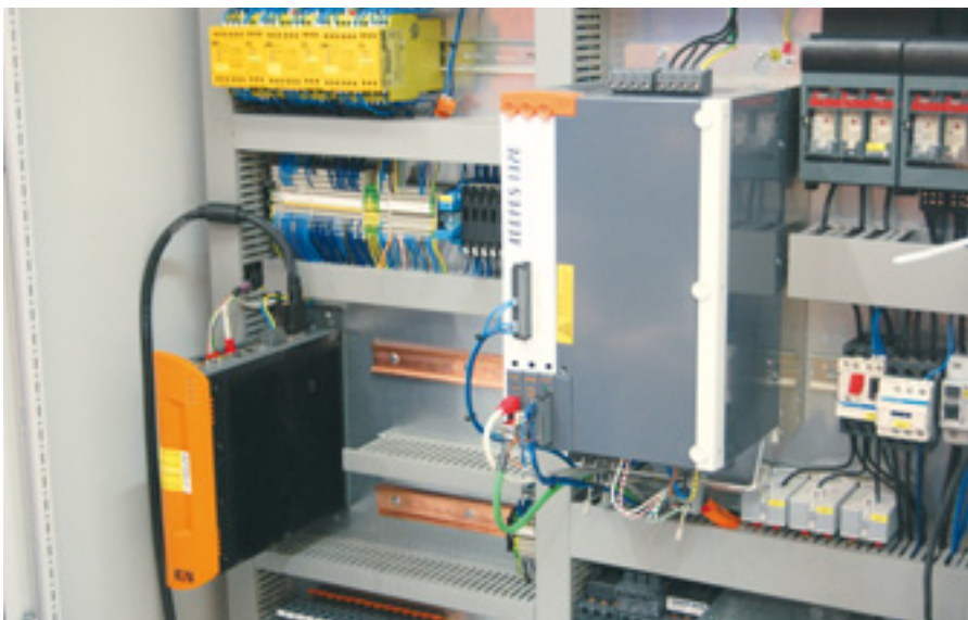
Der Acopos-Servoverstärker ist über Powerlink mit dem Steuerrechner APC620 verbunden
