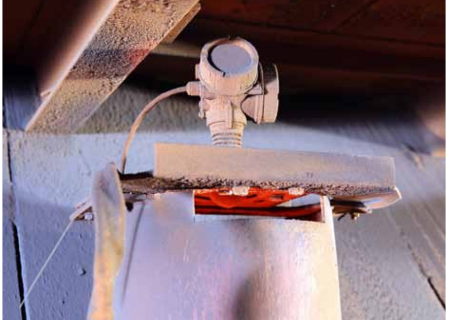
Die PTFE-Beschichtung des Radar-Füllstandsmessgeräts Micropilot FMR52 verhindert Ablagerungen an der Antenne und macht eine Reinigung überflüssig. Alle Fotos wenn nicht anders angegeben: voestalpine Stefan Aichhorn.
