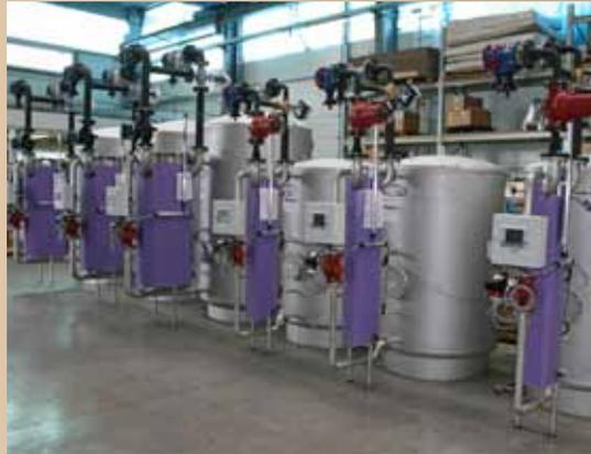
**links** Die Wärmetauscher für die Warmwassererzeugung sind besonders energieeffizient. Steuerung und Visualisierung erfolgt mittels Control Panels HZS 555 mit 5,7" VGA TFT-LCD-Farbtouchdisplay und EDGE-Technology von Sigmatek.
