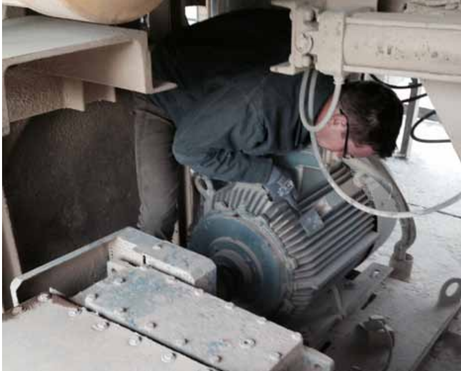
Im Valentiner Asphaltmischwerk ließen ein erhöhter Stromverbrauch und verdächtige Geräusche am Stirnradgetriebe des Hauptmischerantriebes einen herannahenden Stillstand befürchten. Foto: SEW-Eurodrive
