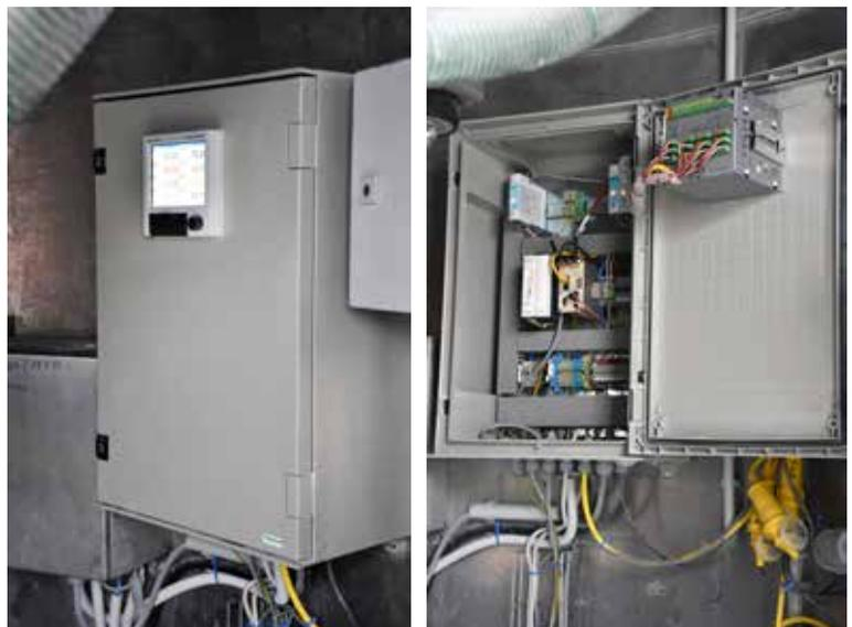
In einer Datentransfer-Box werden die Daten aus den Messgeräten konzentriert und per GPRS-Modul zu Endress+Hauser übertragen. Ein Datenlogger Ecograph T RSG35 dient zur Vorverarbeitung und Zwischenspeicherung sowie zur örtlichen Kontrolle der Daten.
