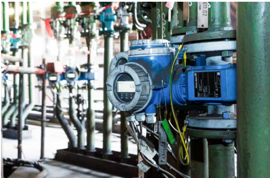
Zum Einsatz kamen u. a. magnetisch-induktive Durchfluss-Messgeräte zur kontinuierlichen Überwachung des Wassers in den Kühlkreisläufen. (Bild: Elin)
