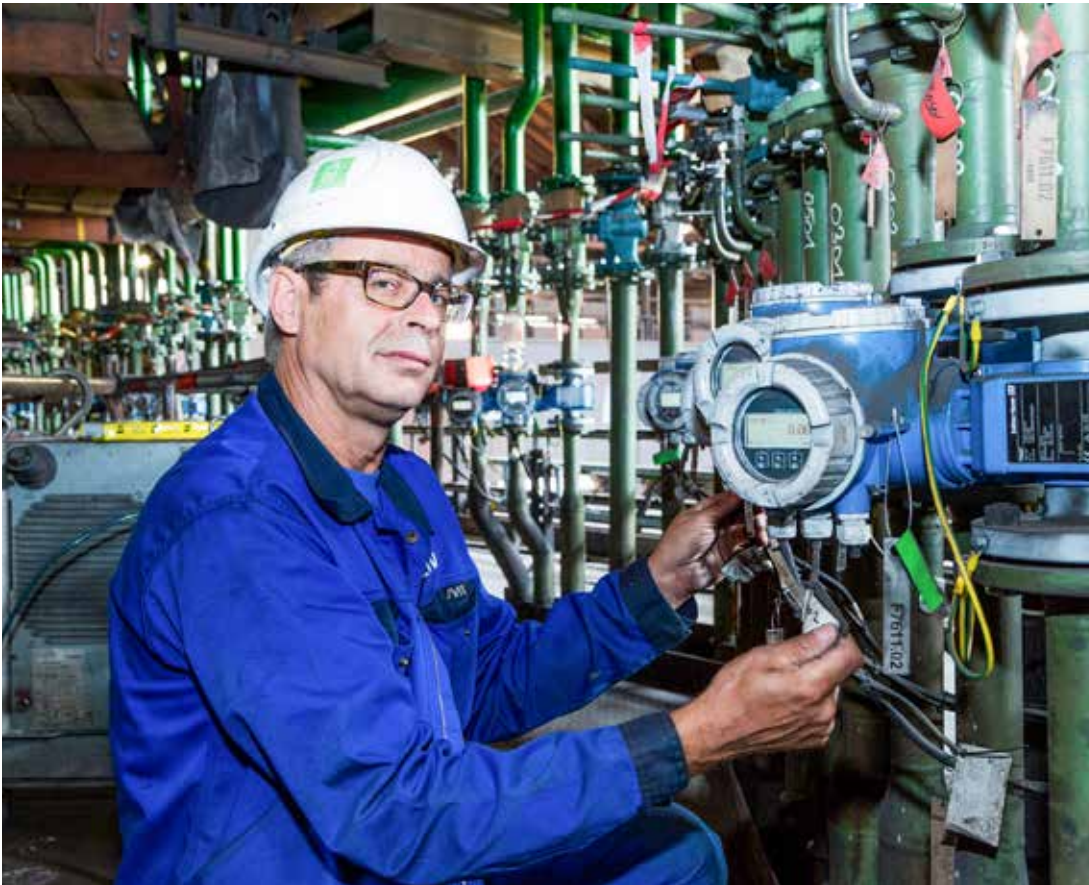
Elin stattete den Hochofen mit rund 600 Messgeräten von Endress+Hauser aus. (Bild: Elin)
