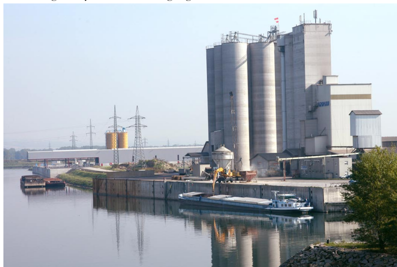
Der ecoplus Gewerbepark in Ennsdorf – © Korosa
