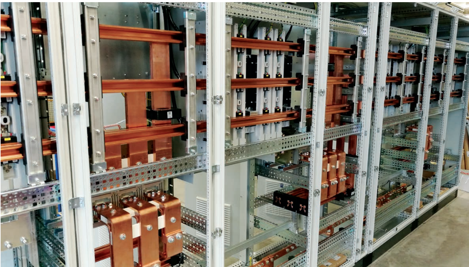
Klampfer verwendet Schaltschränke und Zubehör von Rittal und ist Rittal-Partner für das modulare Produktportfolio Ri4Power, mit dem sich Energieverteilungssysteme bis 6.300 A sehr effizient aufbauen lassen.
