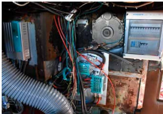
**links** Das gesamte Schiff wurde neu verkabelt, die zentralen Elemente der Stromversorgung mit den Akkus (im Hintergrund) sowie den Lade- und Schutzschaltungen (links) im Motorraum untergebracht.
