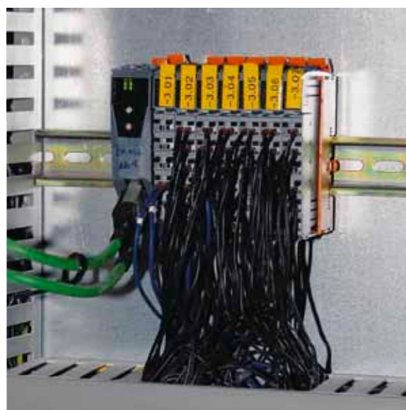
I/O Knoten mit B&R X20 Systemen an POWERLINK.
