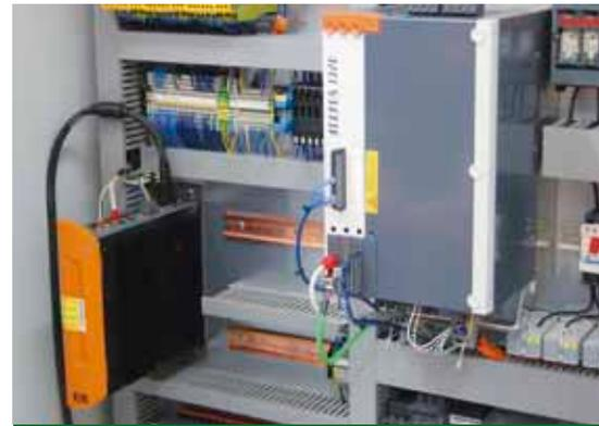
Der ACOPOS Servoverstärker ist über POWERLINK mit dem Steuerrechner APC620 verbunden.
