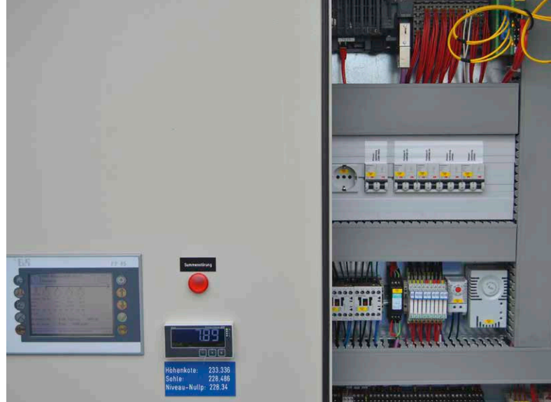
Jede der über 120 mittels Ringredundanz vernetzten Stationen wird von einer dezentralen SPS der Serie X20 von B&R mit rund 100 Ein- und Ausgängen gesteuert. Als lokale Bedien- und Visualisierungsgeräte werden Power Panel 45 eingesetzt.
