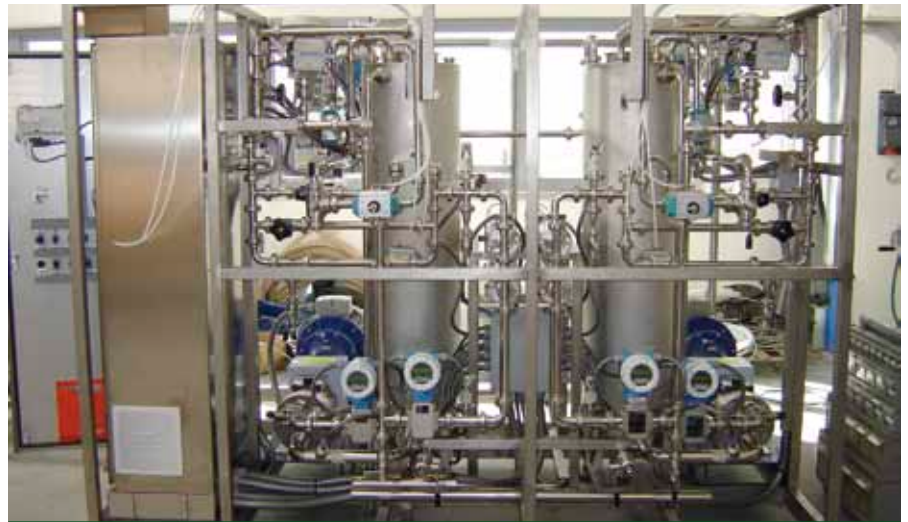
Die einzelnen verfahrenstechnischen Einheiten sind bereits herstellerseitig mit eigenen Steuerungen ausgestattet.
