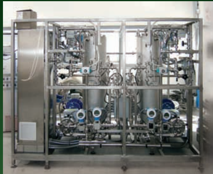
Die einzelnen verfahrenstechnischen Einheiten sind bereits herstellerseitig mit eigenen Steuerungen ausgestattet. Zentralisiert werden sie mit dem Prozessleitsystem »Aprol« und »X20«-Steuerungen von B&R.
