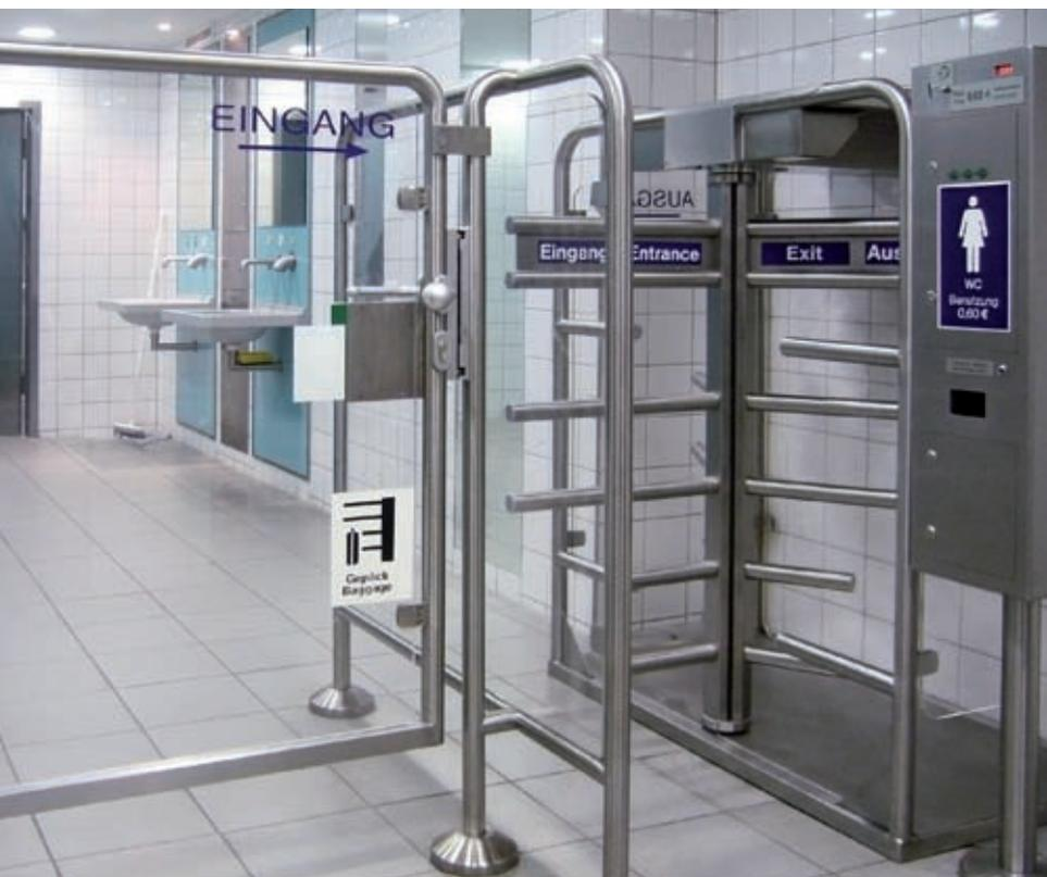
In hoch-frequentierten, öffentlichen Toilettenanlagen werden Drehkreuze mit besonders hoher Übersteigsicherheit eingesetzt. Für die Mitnahme von Gepäckstücken gibt es ausreichend Raum im Fußbereich der Geräte.
